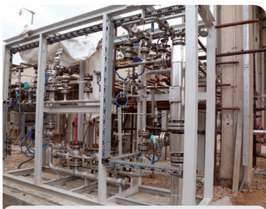
نصب پکیج جداسازی گاز اتیلن شرکت Borsig آلمان
